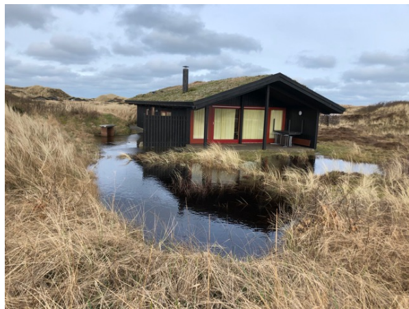
Foto 3 - Opstigende vand ved S. 44
